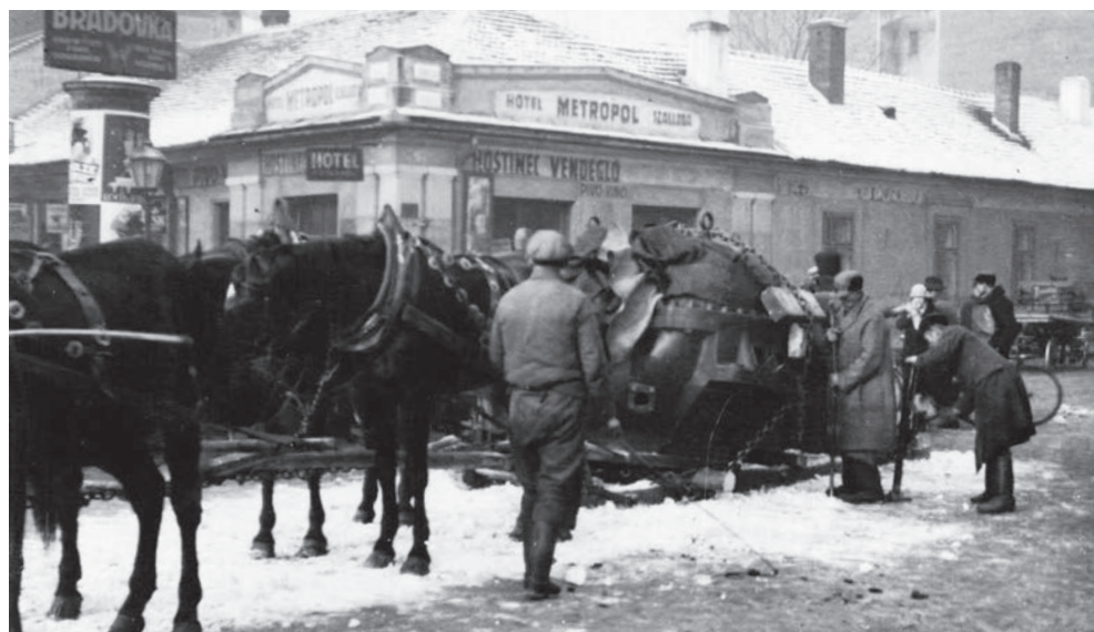
Dovoz parnej turbíny do košickej Mestskej elektrárne
