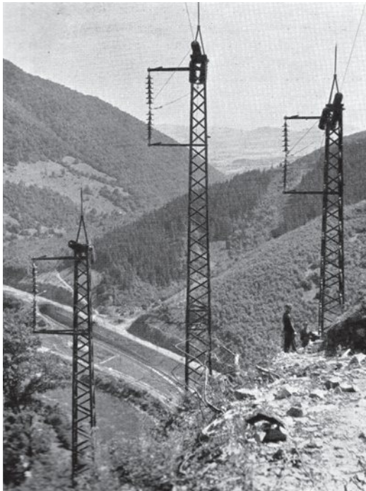
Stavba 100 kV vedenia Žilina – Vrútky
