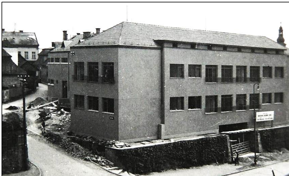
Novostavba okresního soudu s věznicí krátce před dokončením (foto: J. Krám, Průvodce Rychnovem nad Kněžnou)
