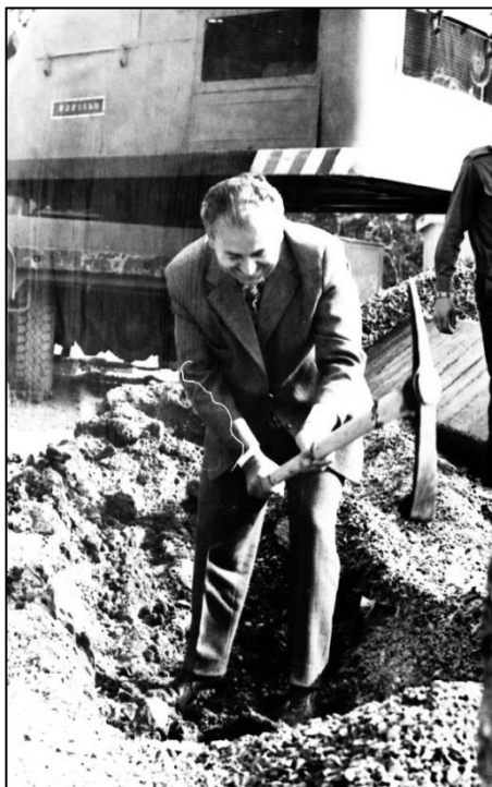
Ministr vnitra Jaromír Obzina při slavnostním výkopu základů areálu VŠ SNB (foto: ABS, f. Muzeum SNB)
