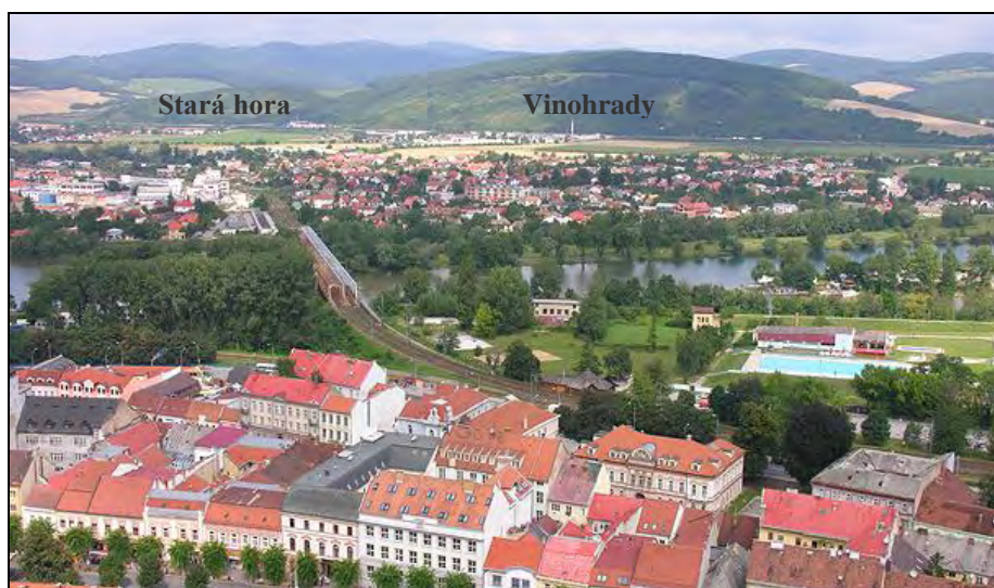
Obrázok 22. Vážska niva je v oblasti Trenčianskeho prielomu intenzívne zvyžívaná. Ohrádzovanie koryta rieky umožnilo budovanie infraštruktúry v mestských častiach Centrum (vpred) a Zámestie (vzadu). Napriek úprave vodného toku ide o územie s rizikom záplav, čo však ÚPN ani UAS CMZ neberú na zreteľ a v dotknutých urbanistických obvodoch naďalej počítajú s rozširovaním zástavby. V pozadí svahy Bielokarpatského predhoria (SZDrpkl) s mozaikou polí a úhorov s NSKV. Hranica medzi kultúrovanou a lesnou krajinou v tomto GsT je zreteľne viditeľná; ide o pozostatok skultúrovania územia v 16. storočí, kedy v lokalitách Vinohrady a Stará hora vznikli vinice. Autor: P. Chrastina (IX., 2005)
