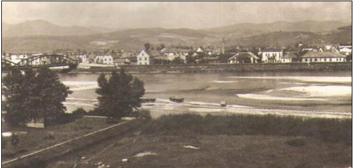
Obrázok 11. Pohľadnica z r. 1935 zobrazuje koryto a pravobrežie Váhu powyše bývalého cestného mosta v Trenčíne. V riečisku vodného toku (v popredí pri štrkových laviciach) v tomto období prebiehala ťažba štrkov, ktoré sa dopravovali banskými vozíkmi po dočasných koľajniciach na stavbu hrádze. Technická úprava brehov rieky v dvadsiatych rokoch minulého storočia umožnila stavebný rozmach Zámestia, ktoré dovtedy (resp. bývalé obce Žabinec, Istebník a Orechové) ohrozovali povodne. Zdroj: Hanušin (2004)
