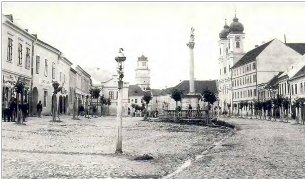
Obrázok 10. Vážske okruhliaky sa používali nielen ako stavebný materiál, ale aj na úpravu verejných priestranstiev. Na obrázku z r. 1898 je centrum Trenčína (dnes Mierové námestie) dláždené okruhliakmi. Takto spevnený povrch námestia vydržal do r. 1927, kedy bol nahradený dlažbovými kockami. Architektúra SZ okraja námestia (na zábere vpravo) bola honosnejšia a bývali tu majetnejší občania mesta. Dôvodom bolo aj väčšie množstvo snežného svitu, ktoré dopadalo na túto stranu. Autor: M. Stern (1898 in Trenčianska nadácia, 2002)
