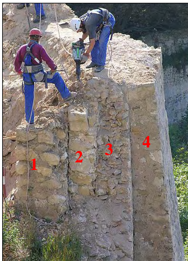
Obrázok 15. Kryštálické bridlice (svory) a sedimentárne horniny (najmä pieskovce, vápence a dolomity, menej sliene a travertíny) tvoria murivo Z časti opevnenia Trenčianskeho hradu. Z obrázka vidno, že fortifikácia nie je homogénna; jednotlivé štruktúry (označené číslom 1 až 4) sa líšia nielen obdobím svojho vzniku (najstarší – vnútorný múr č. 1 postavili v polovici 15. storočia), ale aj použitým materiálom. Rozoberanie muriva (zrútilo sa v júni 2003 v dôsledku nedostatočnej údržby) vyžadovalo horolezecký výcvik a špeciálne vybavenie pracovníkov. Podobné materiálové zloženie ako predmetný úsek defenzívnej architektúry hradu má i mestské opevnenie z 15. storočia v pozadí. Autor: P. Chrastina (IX. 2005)
