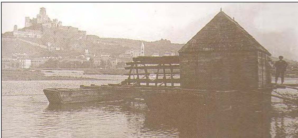
Obrázok 32. Lodný mlyn na Váhu pri Orechovom v r. 1922. Začiatkom 18. storočia bolo v okolí Trenčína 16 takýchto stavieb, na konci 19. storočia, keď sa presadzovali výkonnejšie parné mlyny, ich zostalo len päť. Zdroj: Hanušin (2004)
