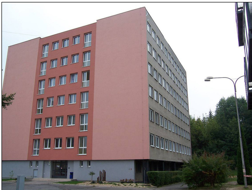
Objekt SOŠ SNV Brno (foto: KDH VS ČR).
