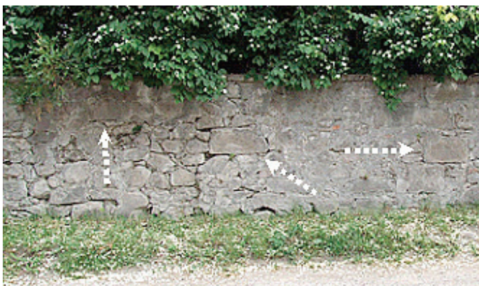
Obr. 17. Kamenárske artefakty z objektu zaniknutého kláštora (ozn. šípkou) tvoria súčasť muriva oporného múru areálu obecnej fary. Od ostatného materiálu sa odlišujú najmä veľkosťou a pravidelným tvarom. Foto: P. Chrastina (16.6.2009)
