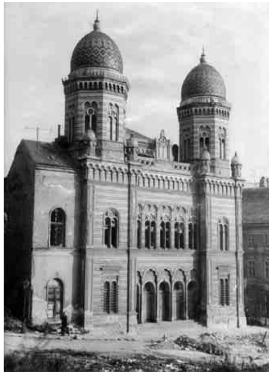
Západná fasáda synagógy s dvoma vežami bola dominantou celej stavby
