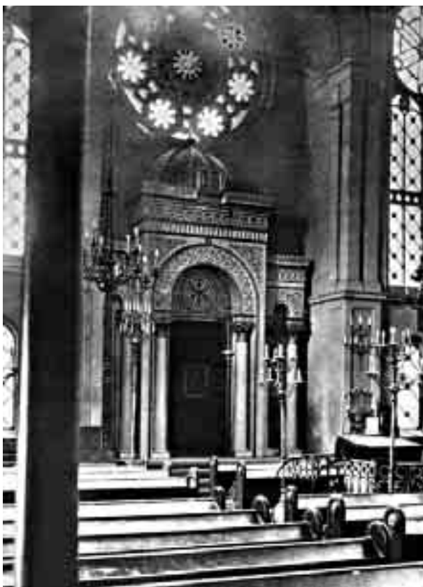
Interiér ortodoxnej synagógy na Zámockej ulici
