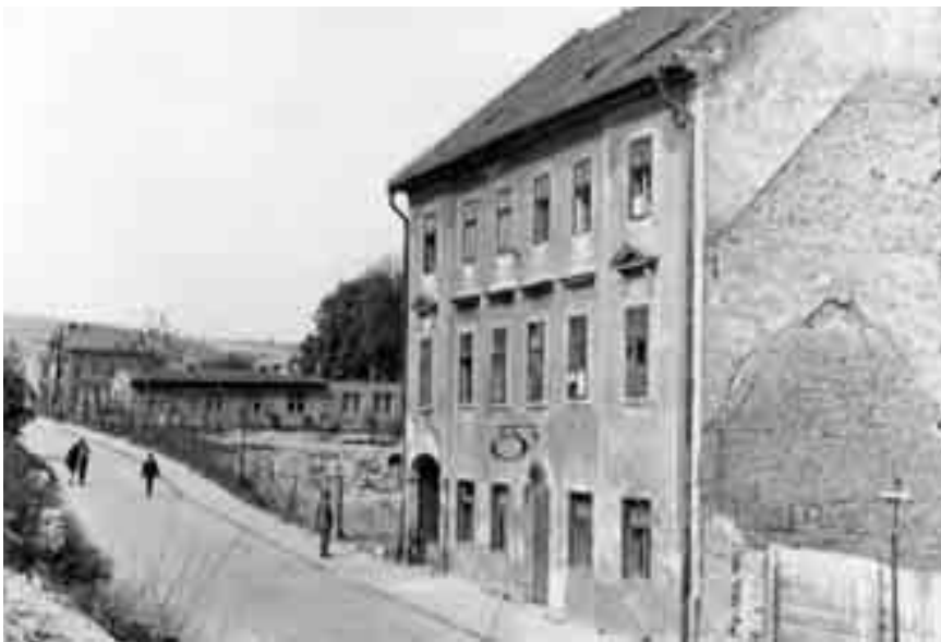
Bývalá krčma na Židovskej ulici. Mala obrovskú pivnicu, kam mohol vojsť aj povoz s nákladom piva. Snímka asi z roku 1968
