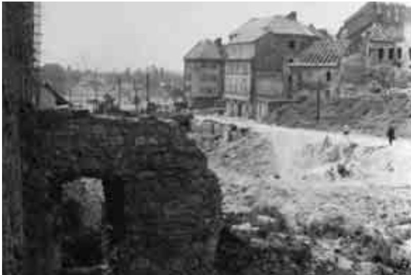
Búranie Židovskej ulice, obnažovanie hradieb a priekopy (1969/70)
