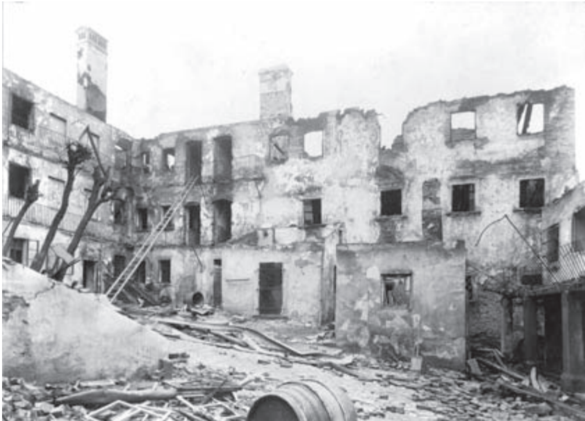
Abb. Nr. 5: Vom Brand beschädigtes Gebäude
