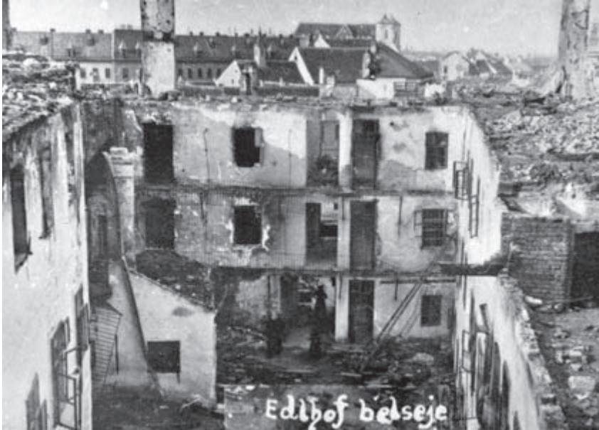
Abb. Nr. 4: Vom Brand beschädigter „Edelhof“
